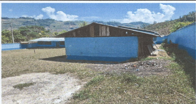
Foto 3: Mejoramiento de aula tipo portico
