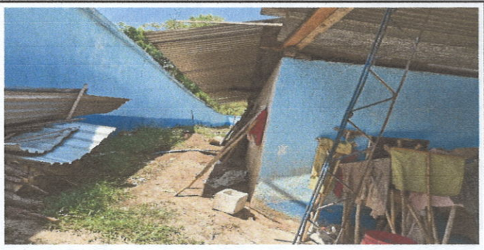
Foto 6: Mejoramiento de aula tipo portico
