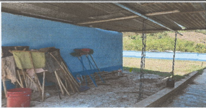
Foto 5: Mejoramiento de aula tipo portico
