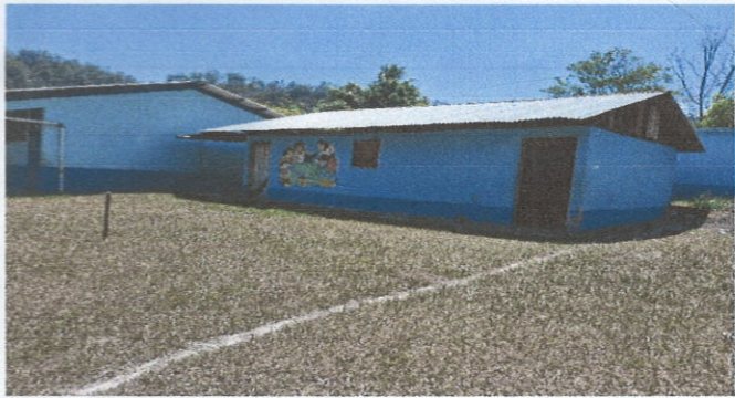
Foto1: Mejoramiento de aula tipo portico
