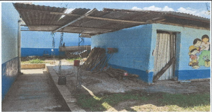
Foto 4: Mejoramiento de aula tipo portico
